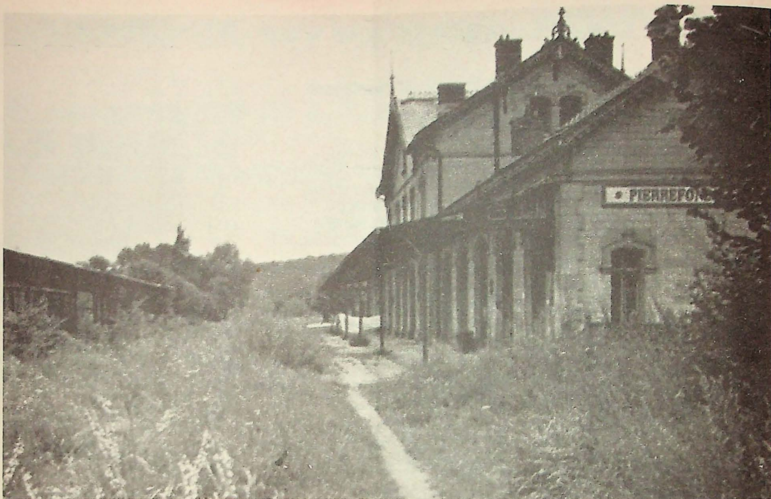
Pierrefonds : voie « déposée », gare désaffectée...
