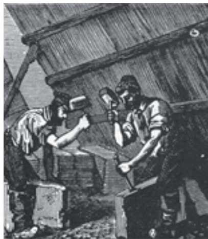
ARDOISIÈRE D'ANGERS - Quand les ardoises ont été arrachées à la carrière par gros blocs, on les fond.
